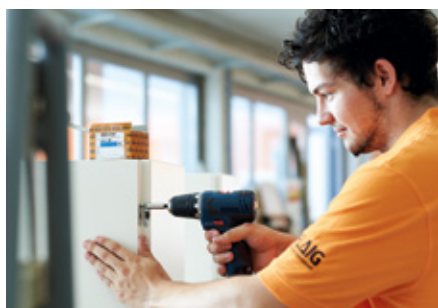
Montage van beslag aan kopse kant
