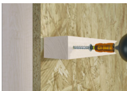
Bevestiging van regelwerk t.b.v. installaties
